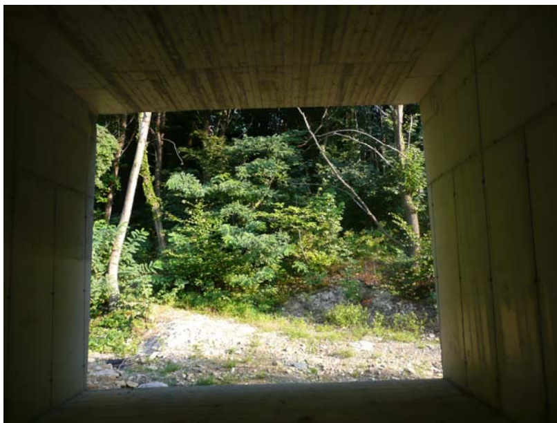
Attraversamento per gli ungulati con le due prospettive a monte e a valle
